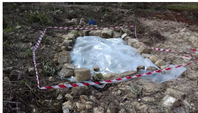
Figura 4.39: Delimitazione e messa in sicurezza dei manufatti potenzialmente contenenti amianto
